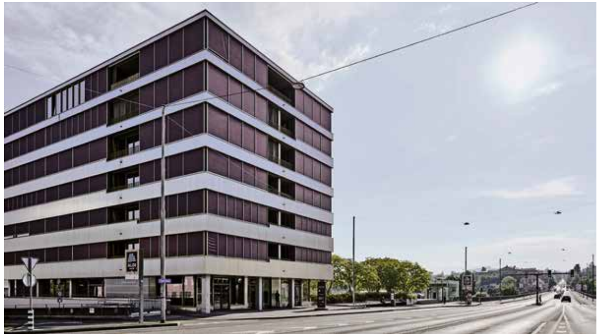
Gesamtansicht, für den Fotografen makellos zurechtgemacht. Im Tagesbetrieb wirkt das Gebäude aber viel nahbarer. (Foto: © Stiftung Berner Baukultur / Rolf Siegenthaler)
