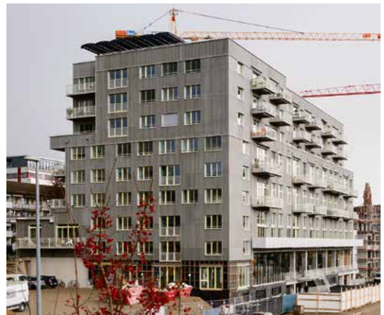
Das ehemalige Lagergebäude erfuhr eine massive Umnutzung und steht heute als Flaggschiff unter den verschiedenen Neubauten am Warmbächliweg. Foto: Jürgen Beck
