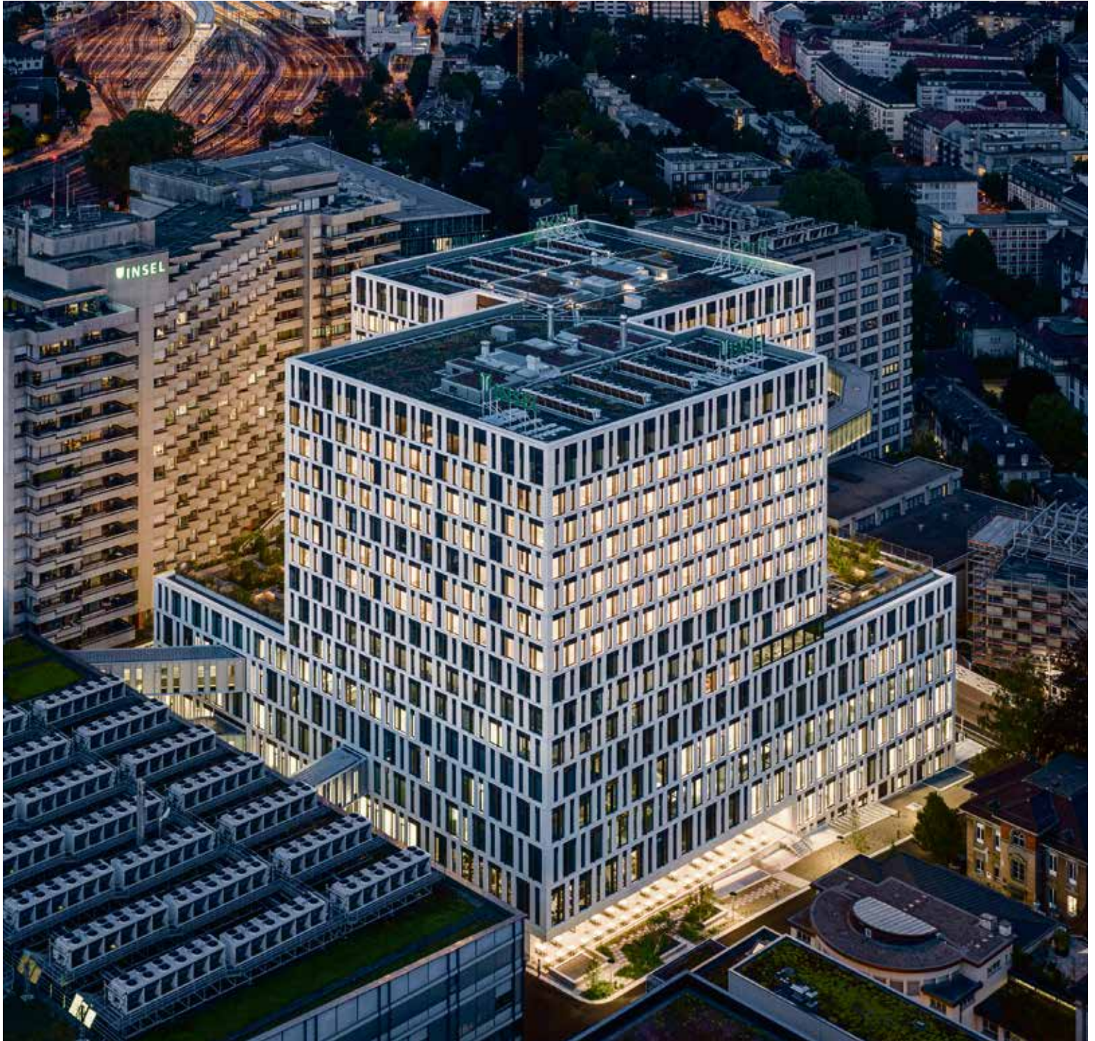
Nur aus der Vogelperspektive wird sichtbar, dass das neue Anna-Seiler-Haus eigentlich aus zwei Türmen auf einem mehrstöckigen Sockel besteht. (Foto: HG Esch) Mehr zu den drei Architekturpreisen der Berner Stiftung Baukultur im Stadtteil 3 auf Seite 14.
